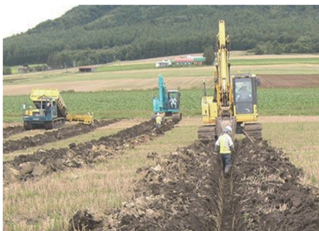
バックホウによる掘削
